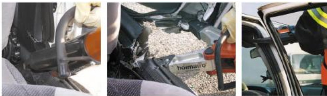
Рис. 7. Технологія перекушування середньої стійки
