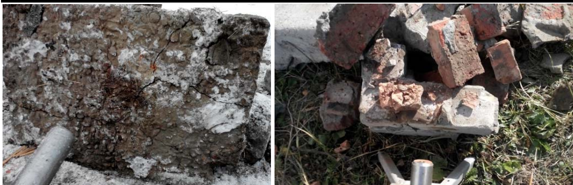
Рис. 4. Будівельні конструкції після руйнування імпульсним водним струменем високої швидкості
