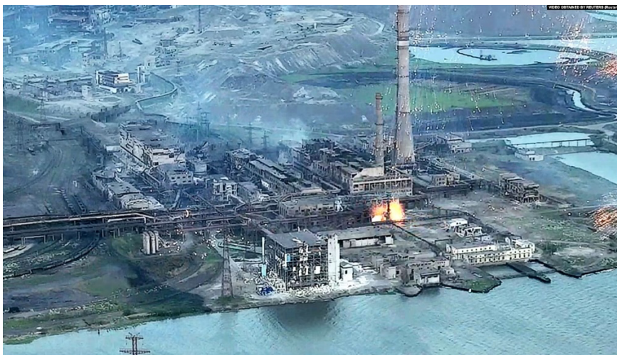
Рисунок 1 – Зруйнований завод «Азовсаль» на березі Азовського моря 15 травня 2023 року
