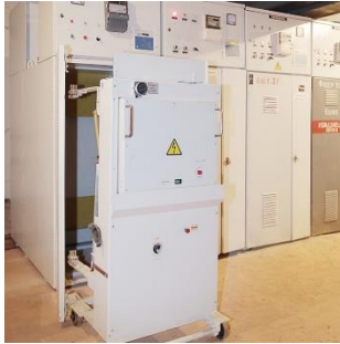
Рис. 1. Комірка високовольтна КРУ-2-10 з викотним елементом – високовольтним вимикачем в складі діючої електроустановки
