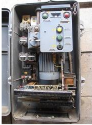
Рис. 2. Шафа автоматики РПН з двигуном перемикання положень
