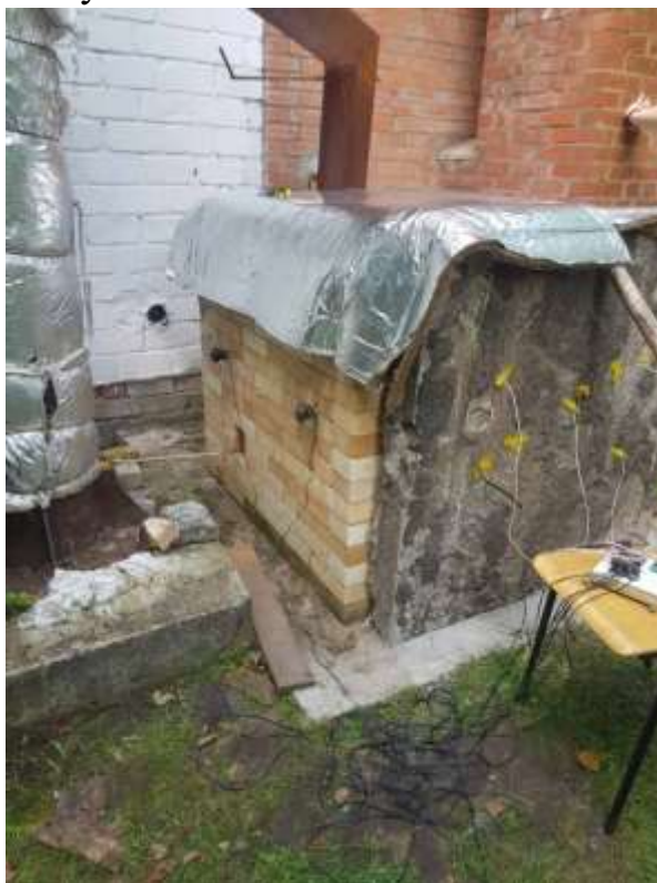
Рисунок 1 – Дослідження з нагрівання малогабаритного фрагмента несучої залізобетонної стіни
