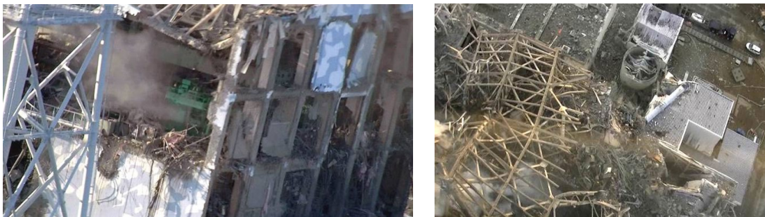
Рис. 1. Фото руйнувань на АЕС "Фукусіма-1".
