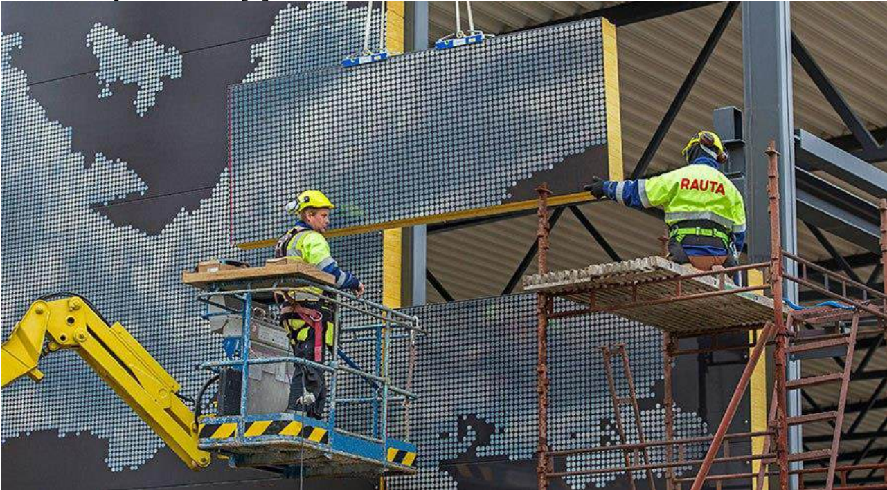
Рисунок 1. Монтаж готових стінових сендвіч панелей [7].
