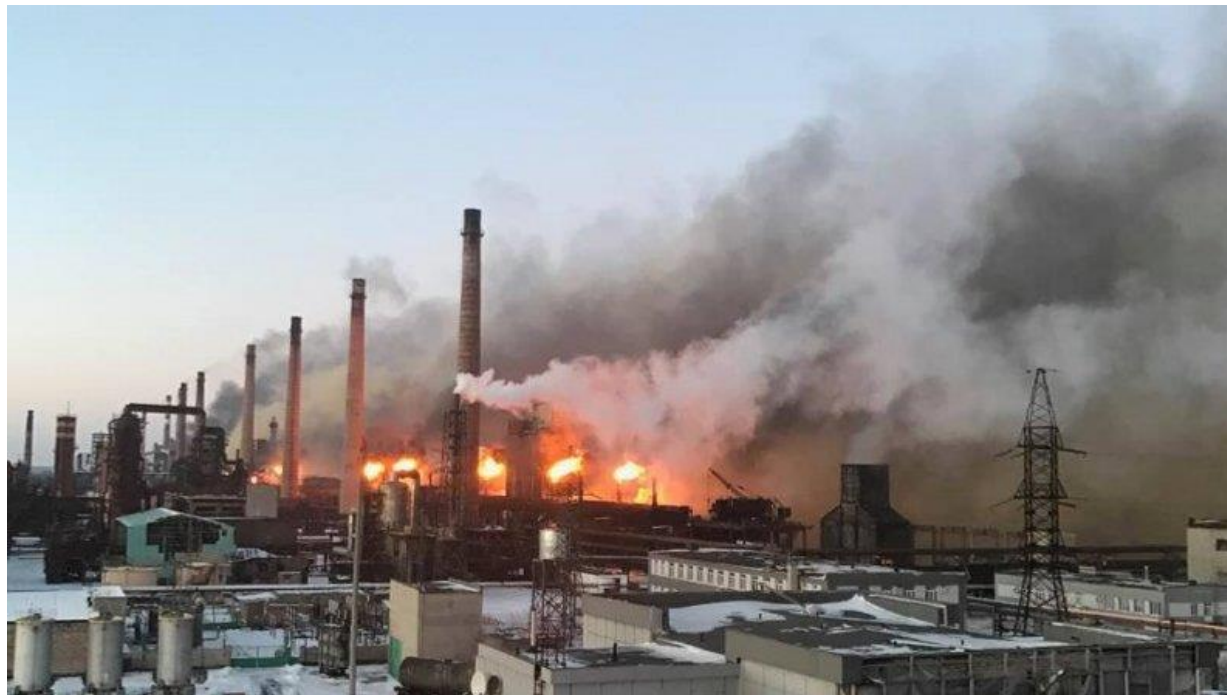
Рис.1. Наслідки обстрілу Авдіївського коксохімічного заводу.
