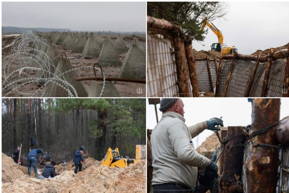
Рис. 3. Створення фортифікаційних загороджень за допомогою інженерної техніки в умовах війни
