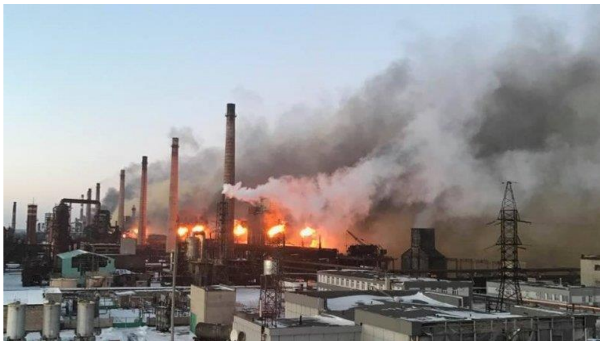
Рис.1. Наслідки обстрілу Авдіївського коксохімічного заводу.
