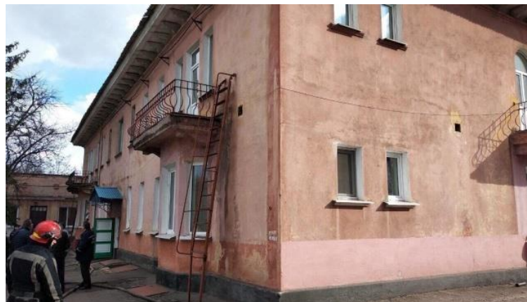
Рис. 2. Пожежа в будівлі дошкільного навчального закладу (м. Кривий Ріг, Україна)
