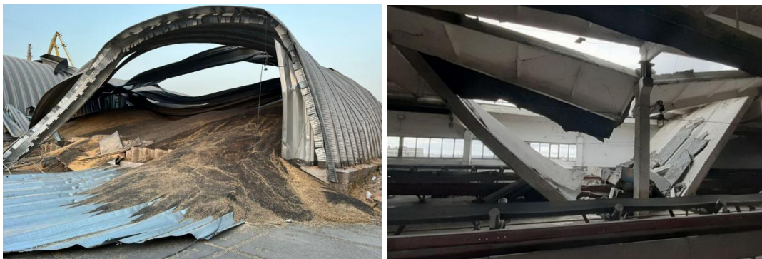
Рис. 1. Приклади руйнувань об'єктів зберігання зерна та зернопродуктів
