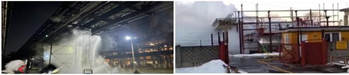
Рис. 1. Пошкодження трубопроводів з НХР
