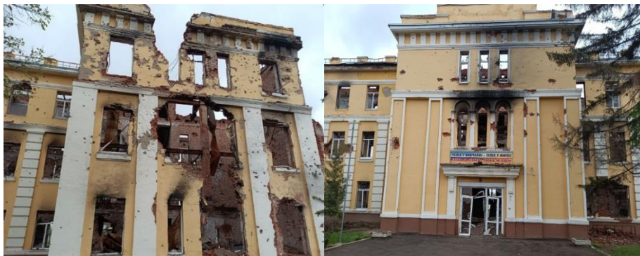
Рис. 1. Фасад будівлі школи № 134.
