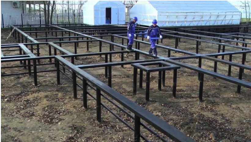
Рис.2. Фундамент на геошурупах
