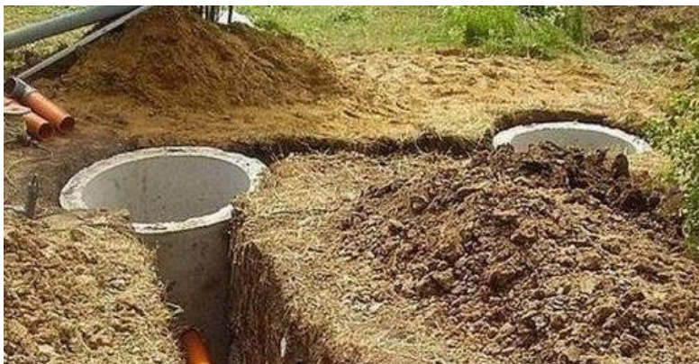
Рис. 1. Вигляд опускового колодязя
