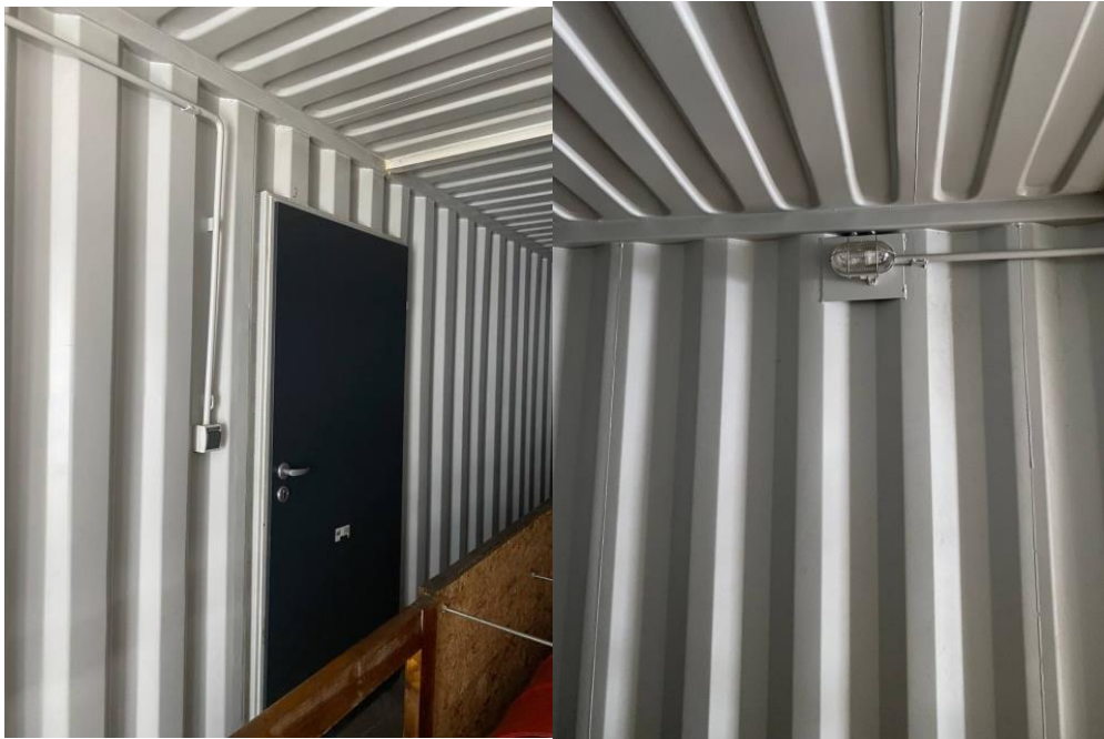
Рис. 9.18. Електричні вимикачі та світильники
