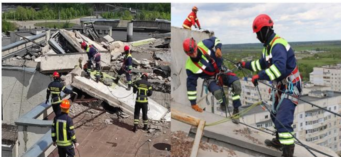
Рис. 1. Позиціонування в опорному просторі при проведенні висотних робіт
