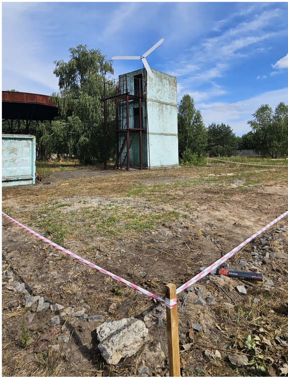
Рис. 1. Зовнішній вигляд макету вітрової електроустановки розміщеної на вогневій площадці
