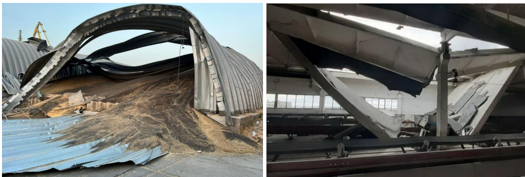
Рис. 1. Приклади руйнувань об'єктів зберігання зерна та зернопродуктів
