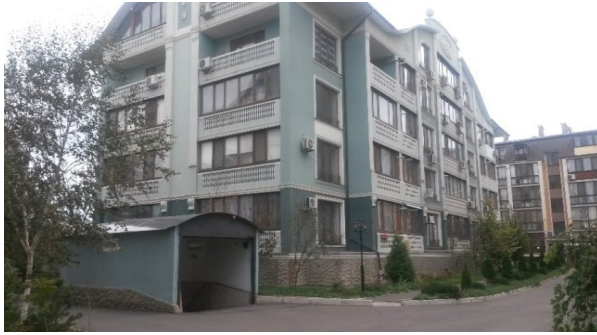
Рис. 2. Загальний вигляд житлової малоповерхової будівлі з підземним паркінгом у м. Одеса
