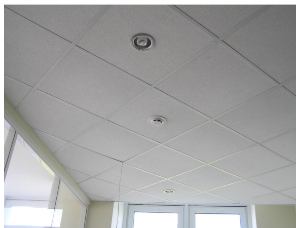
Рисунок 1.3 – Приклади розміщення пожежних сповіщувачів за наявності на стелі світильників
