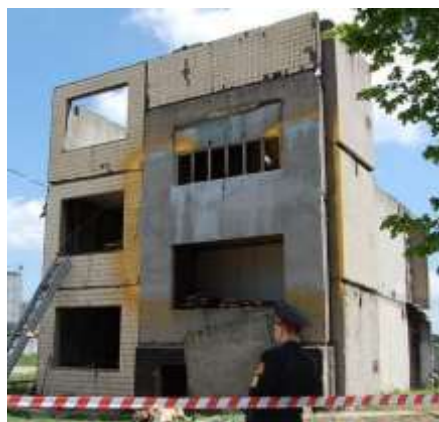
Рисунок 1.3. Повномасштабне пожежне випробування фрагмента великопанельної будівлі
