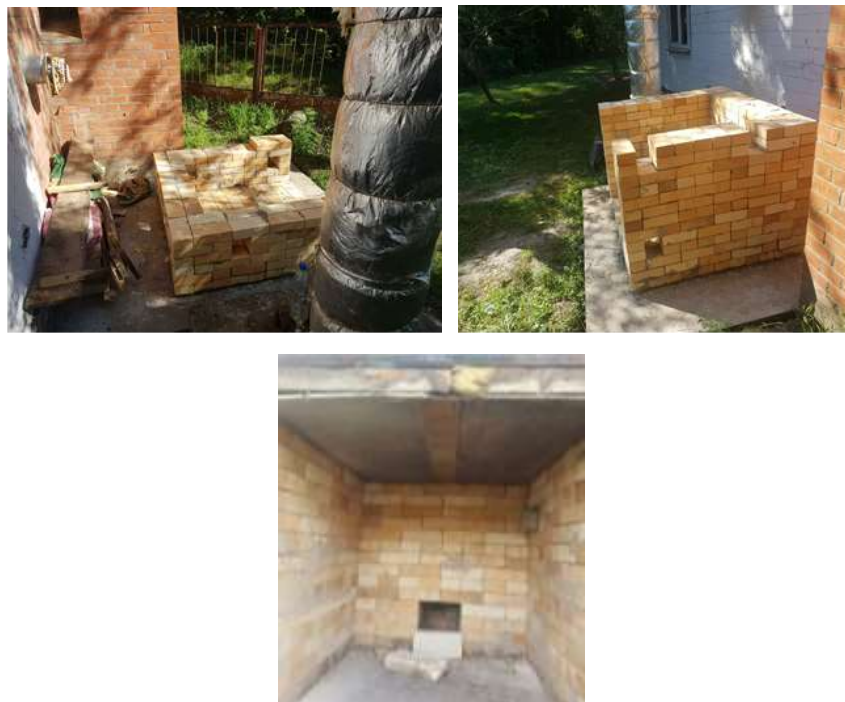
Рисунок 3.4. Отвори для встановлення пальників, один з лівої сторони п-подібного огородження печі та 3 з правої, та отвір для відведення продуктів горіння
