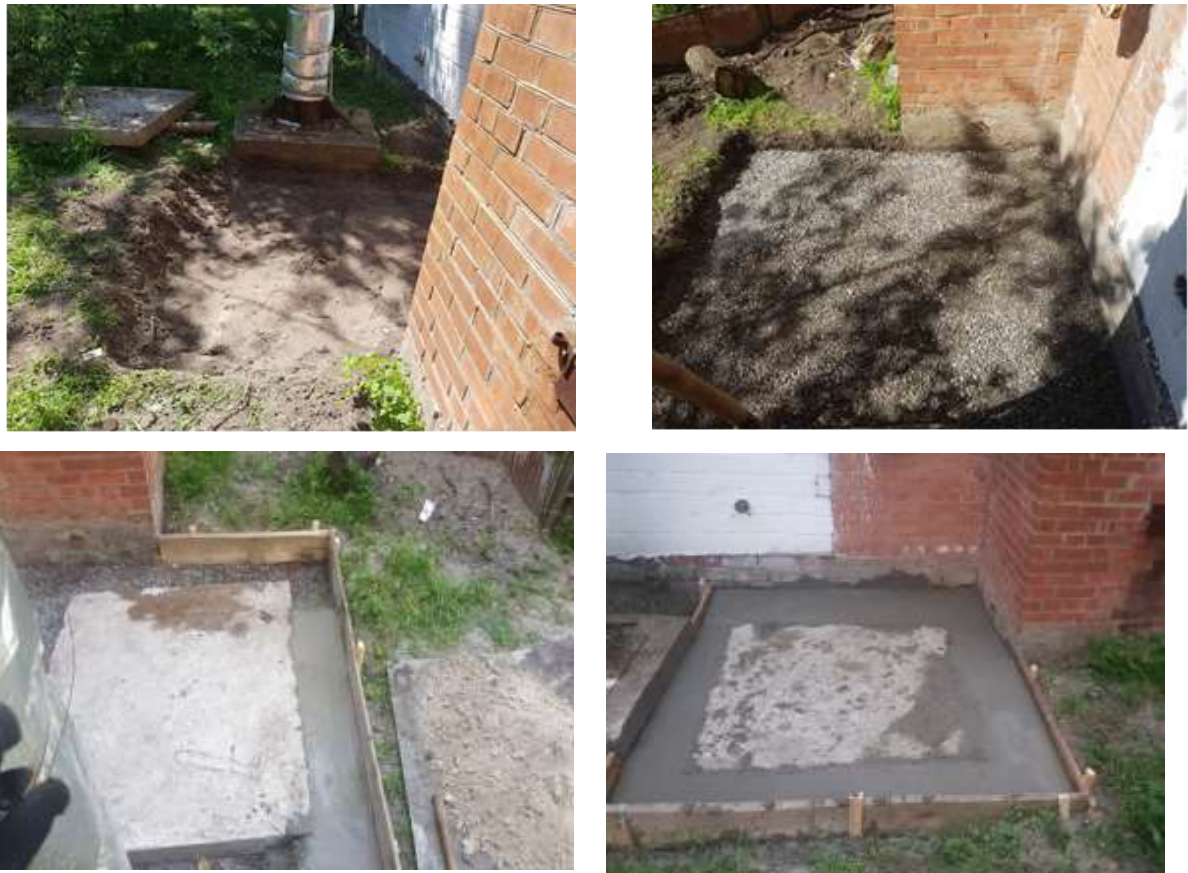
Рисунок 3.2. Створення фундаменту, як основи під камеру вогневої установки [90]
