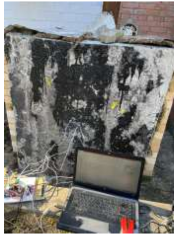
Рисунок 3.16. Фрагмент несучої залізобетонної стіни після виконаного експерименту
