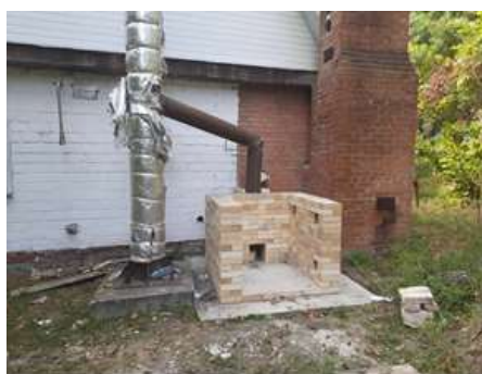
Рисунок 3.5. Димохід камери вогневої установки.
