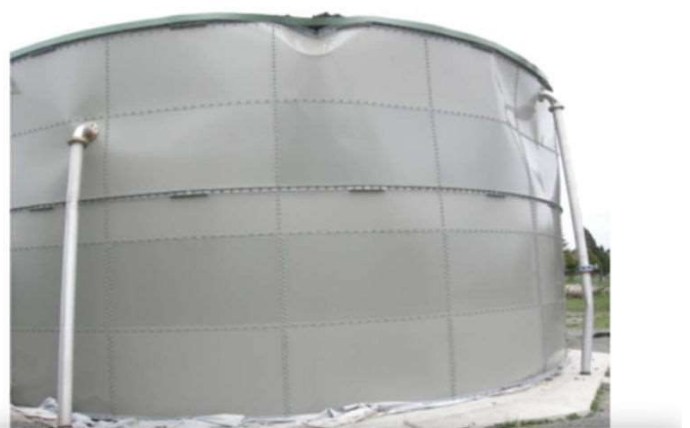
Рисунок 3.5. Пошкодження стіни через коливання рідини (справа), зсув фундаменту (зліва). Дарфілд, Нова Зеландія, 2010 р.
