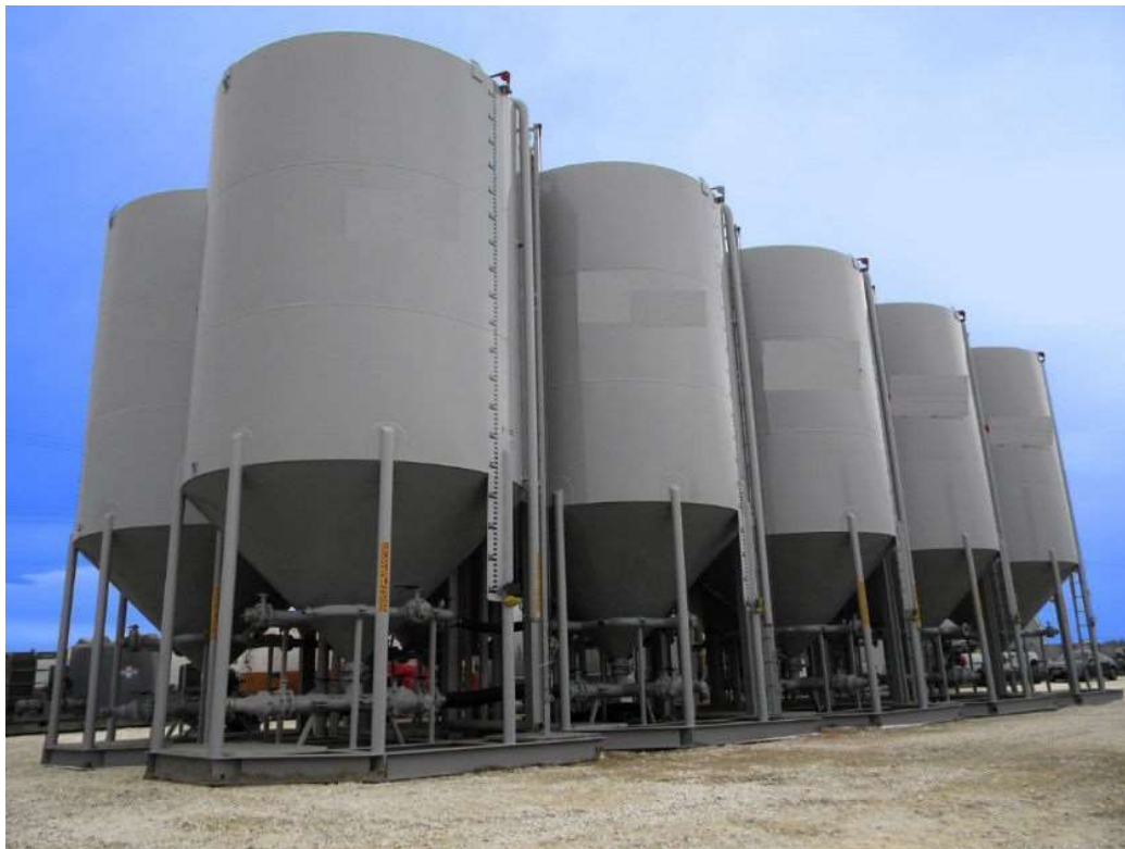
Рисунок 3.8 Резервуар конічної форми.
