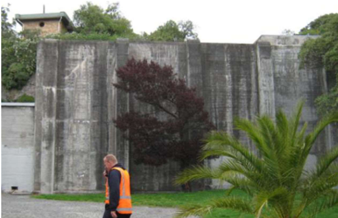
Рисунок 3.6. Призматичний бетонний резервуар, Дарфілд, Нова Зеландія, 2010 р.
