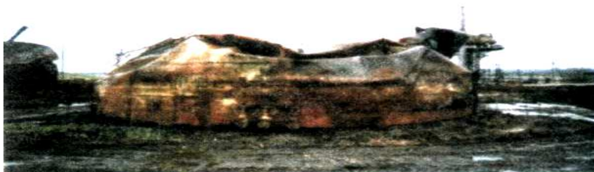
Рис. 2.13. Деформация резервуара в результате пожара сырой нефти
