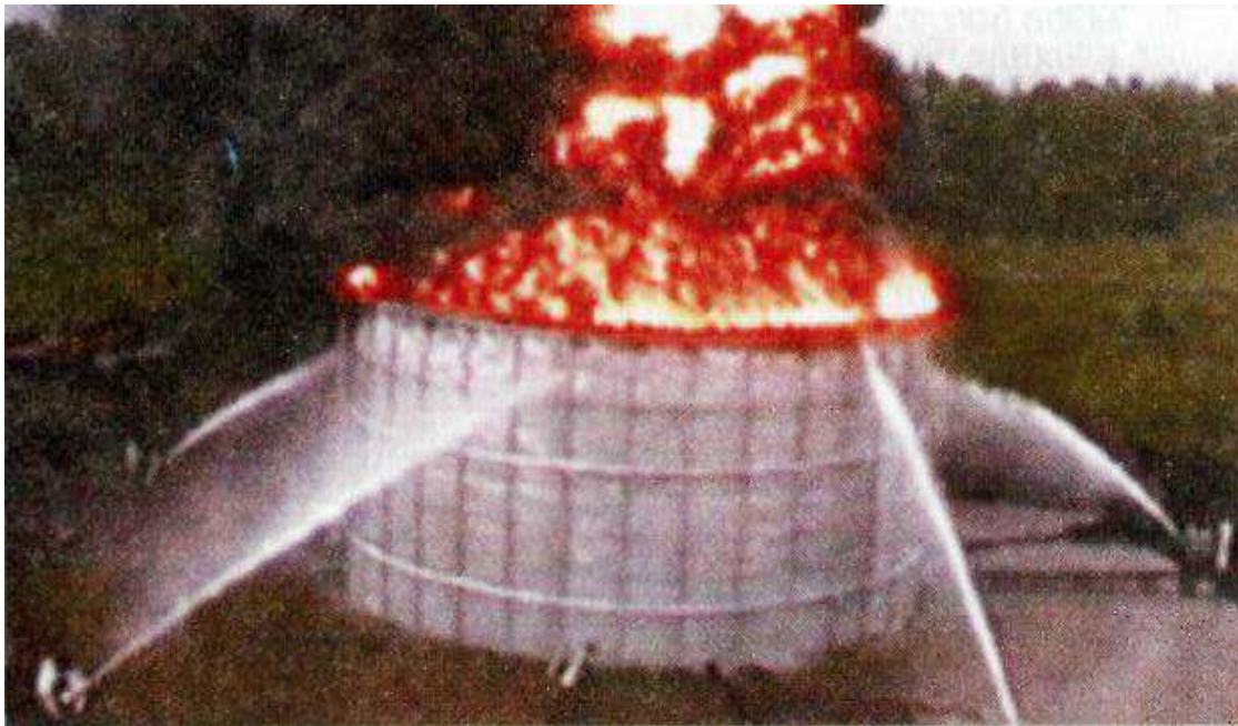
Рис. 1.3. Охлаждение горящего резервуара передвижной техникой
