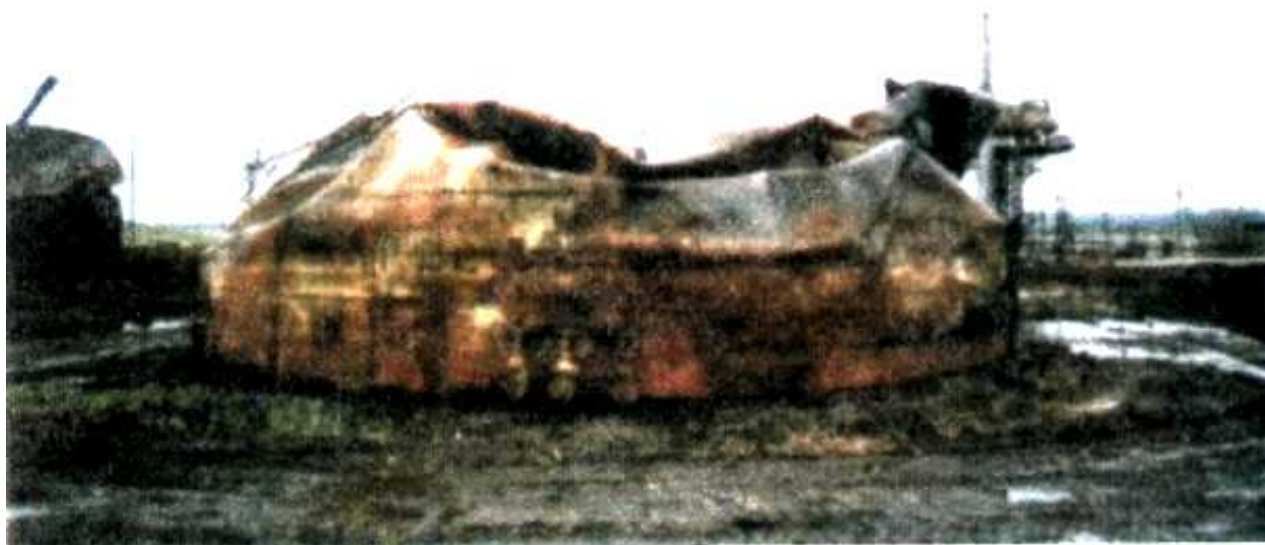
Рис. 1.2. Резервуар «сложился» в результате взрыва и пожара
