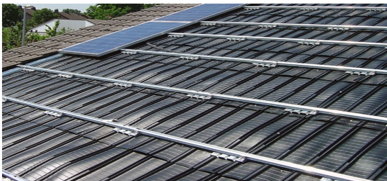
Рис. 2 – Установка системи сонячних батарей на похилій конструкції
