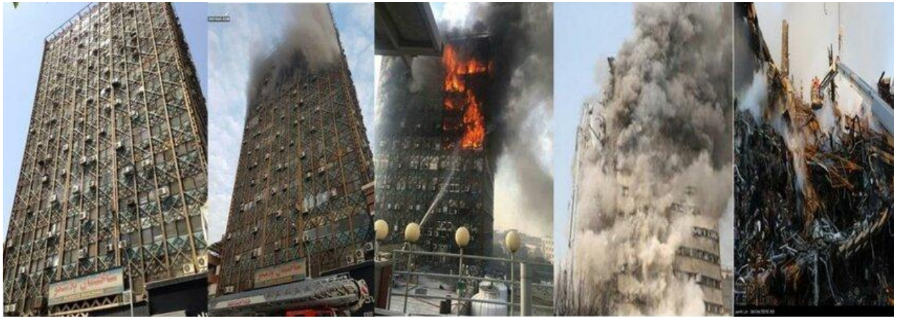
Рисунок 1.4 – Наслідки пожежі у будівлі PLASCO. 2016, Тегеран
