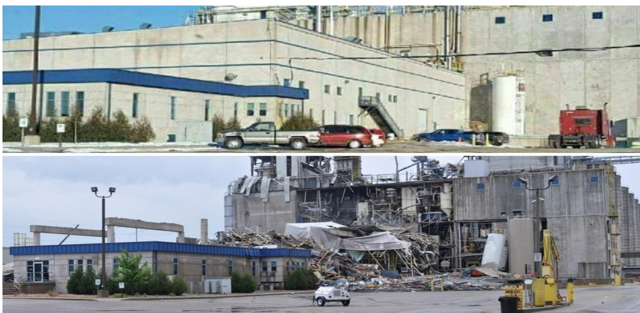
Рисунок 1.9 – Наслідки пожежі та вибуху у будівлі млина
