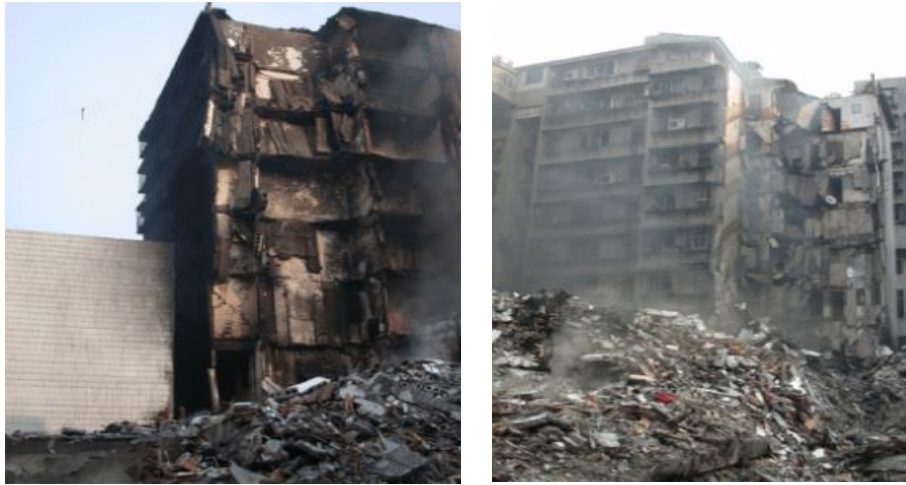
Рисунок 1.6 – Обвалення виробничої будівлі Hengzhou Tower, 2003, Китай
