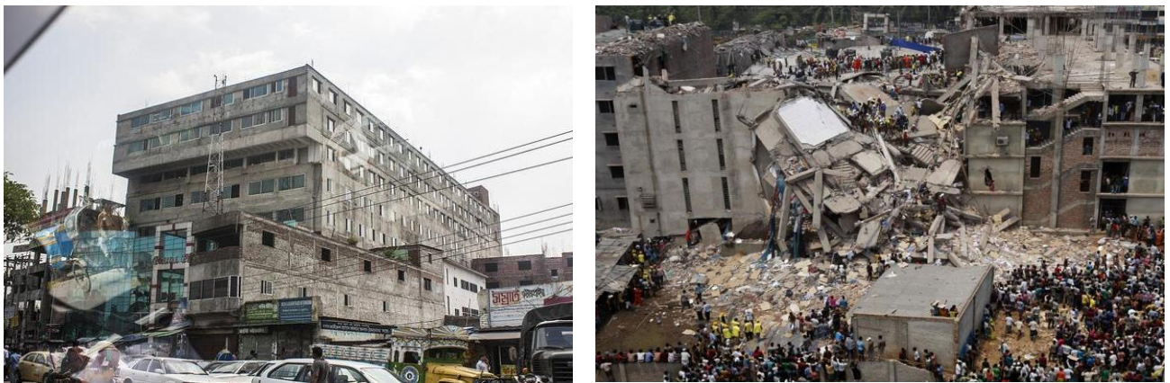
Рисунок 1.7 – Обвалення будівлі Rana Plaza, Савар 2013, Індія
