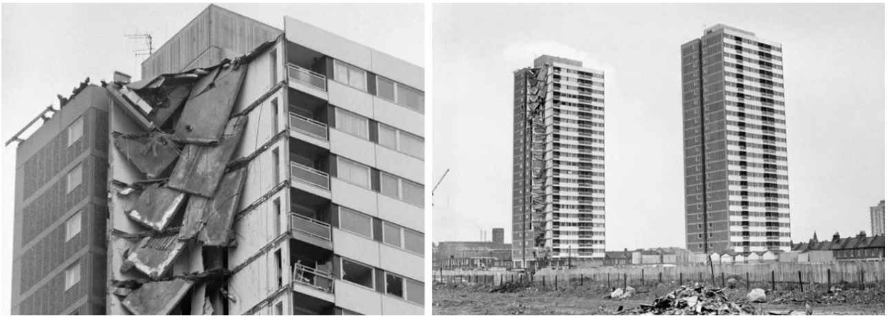
Рисунок 1.1 – Наслідки прогресуючого обвалення житлового будинку після вибуху побутового газу та пожежі в одній із квартир, 1968 рік, Лондон
