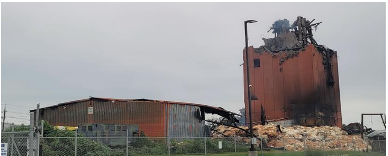
Рисунок 1.11 – Наслідки пожежі та вибуху у будівлі млина
