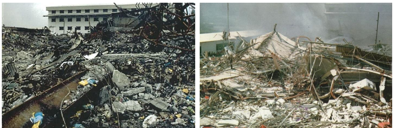
Рисунок 1.5 – Виробнича будівля Kader 1993, Таїланд
