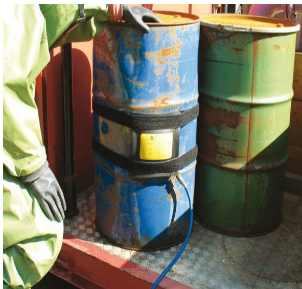
Рисунок 4.11. – Закривання отворів на резервуарах за допомогою бандажів
