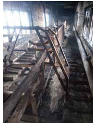
Рис. 1. Наслідки пожежі в галереї подачі первинної сировини на підприємстві з виробництва брикетів торфу
