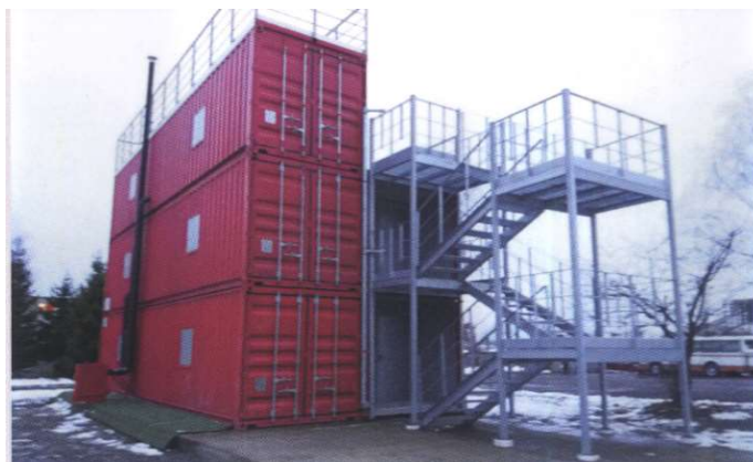
Рисунок 1 – Багатофункціональний тренажер контейнерного типу
