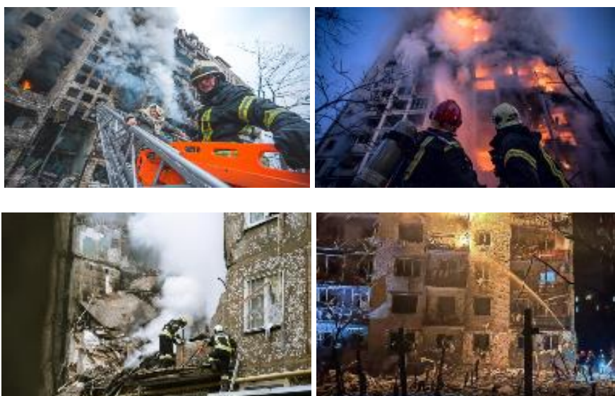
Рис. 1. Стан житлових будівель внаслідок ворожих обстрілів
