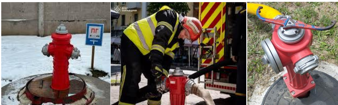
Рис. 1. Наземний пожежний гідрант
