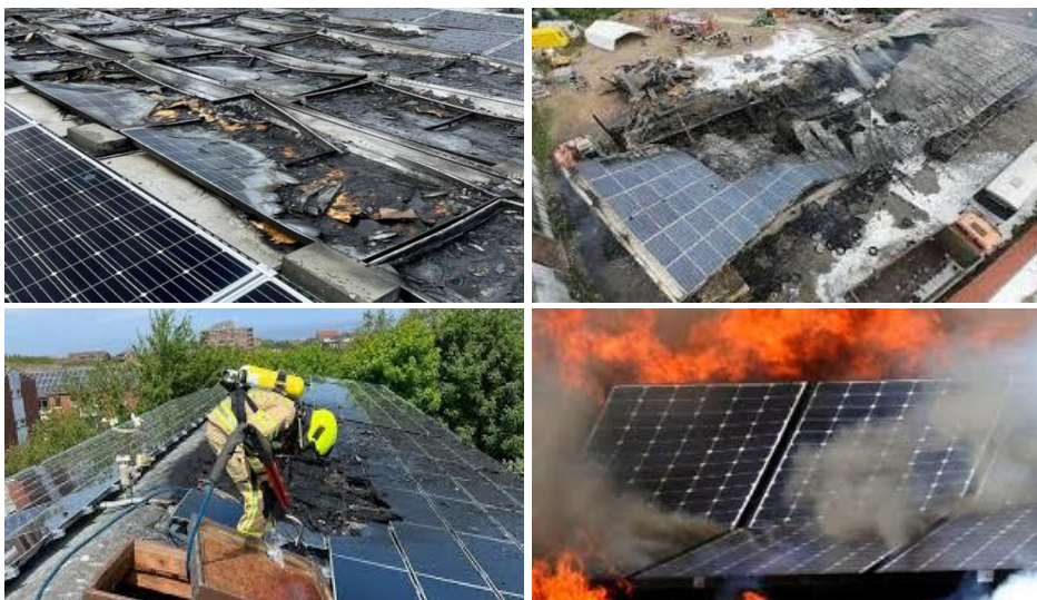
Рис. 1. Стан сонячних панелей внаслідок пожежі
