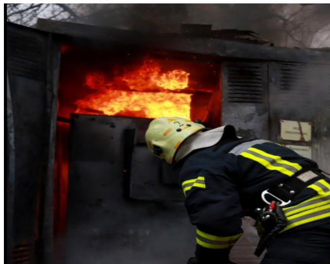
Рисунок 1.4 – Пожежа трансформатору в м. Луцьк
