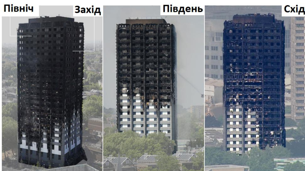
Рисунок 1.4 – Наслідки поширення пожежі по фасаду в наслідок пожежі у будівлі Grenfell Tower в 2017 (Лондон, Великобританія).
