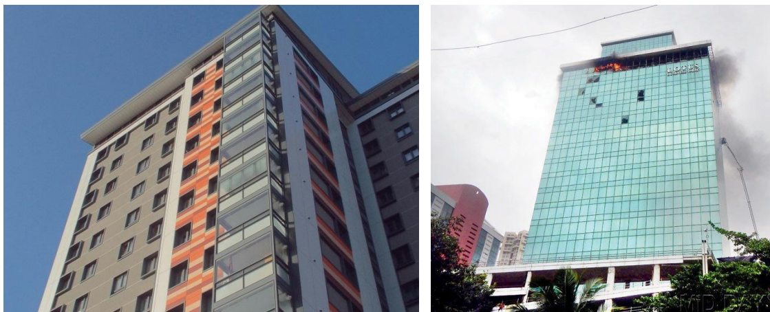
Рисунок 1.9 – Фото будівлі із протипожежним карнизом для захисту експлуатованої покрівлі.
