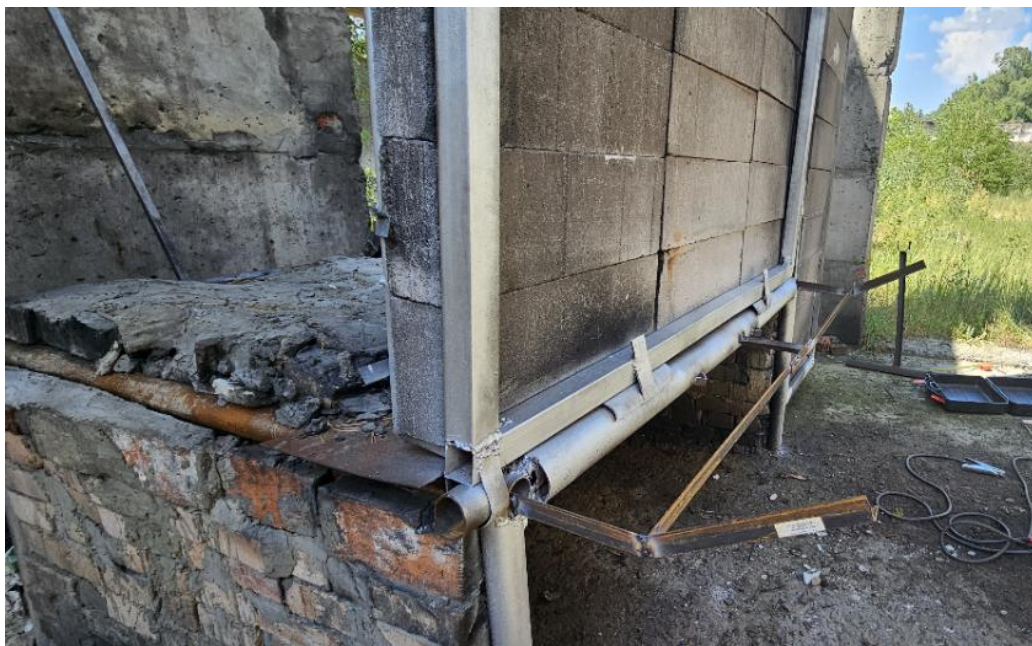
Рисунок 4.2 – Сталевий каркас протипожежного карнизу у формі «вінглету».
