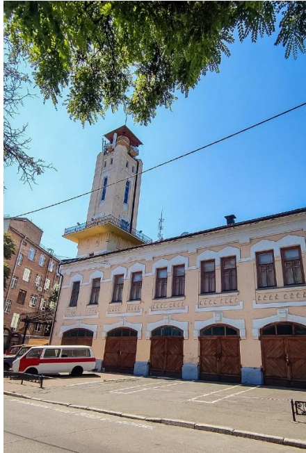
Рисунок 2 – Національний музей «Чорнобиль». Колишня будівля депо Подільської пожежної частини, м. Київ [5]
