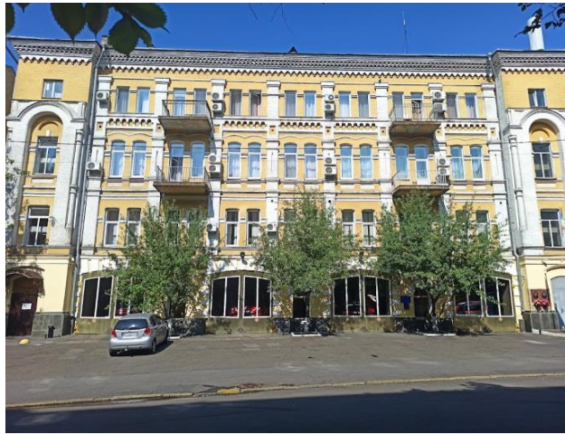
Рисунок 4 – Солом'янське районне управління Головного Управління ДСНС України у м. Києві. Колишня будівля депо Либідської пожежної частини, м. Київ [9]
