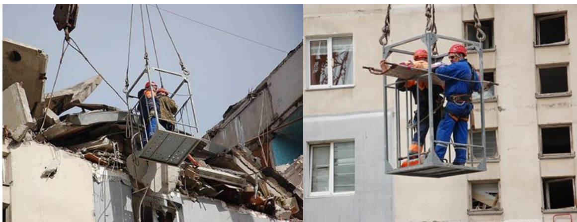
Рисунок 1 – Використання люльки традиційних кранів: а) видалення елементів пошкоджених будівель; б) транспортування постраждалих до землі
