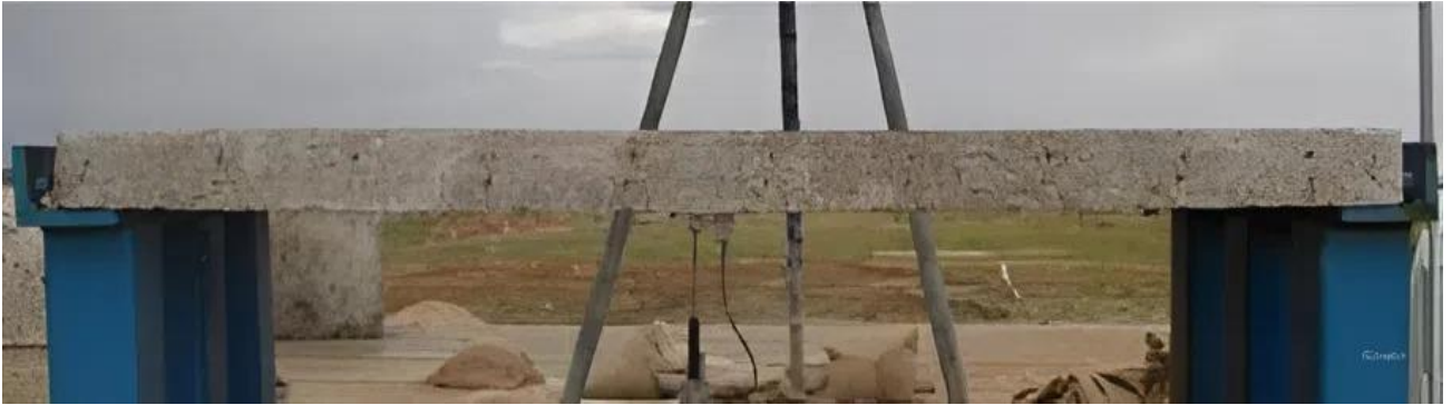
Рис. 2.33 – Вигляд залізобетонної плити після випробування [155].
