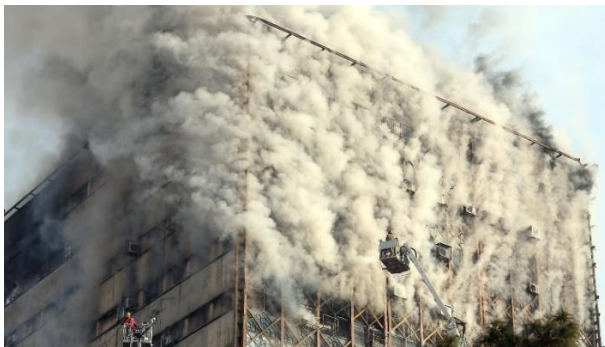
Рис. 1.1 – Пожежа у висотній будівлі Plasco в місті Тегеран, перед обваленням конструкцій
