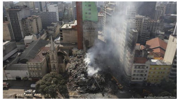
Рис. 1.2 – Наслідки пожежі та обвалення багатоповерхової будівлі в Сан-Паулу
