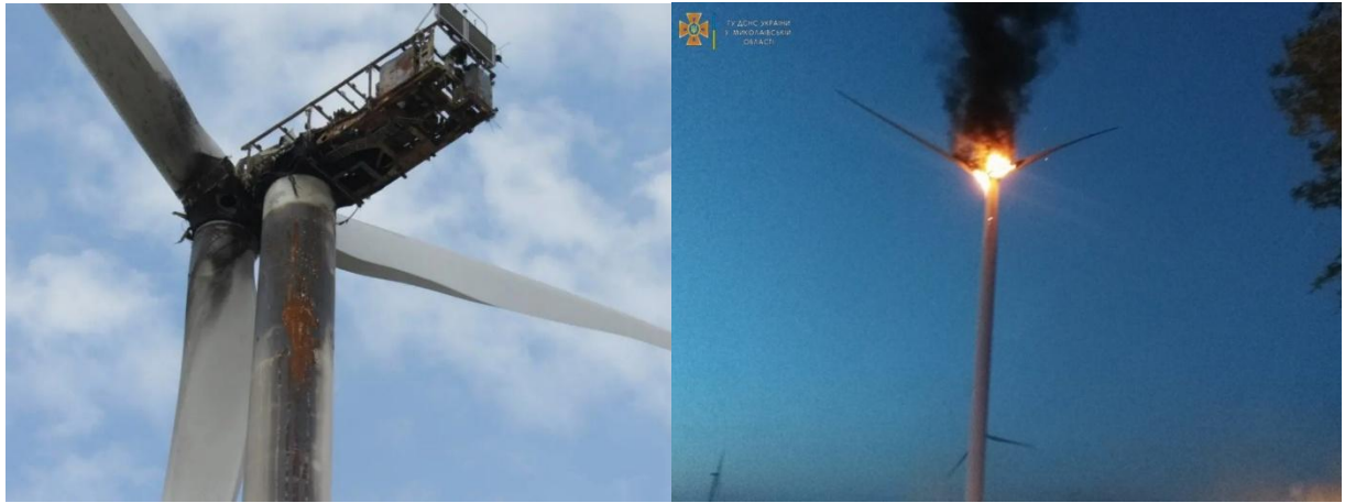
Рисунок 1.2 – Приклад пожежі ВЕУ та її наслідки.
