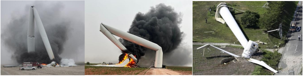
Рисунок 1.4 – Фото руйнувань ВЕУ, що супроводжувалися пожежами та пошкодженням прилеглої інфраструктури.
