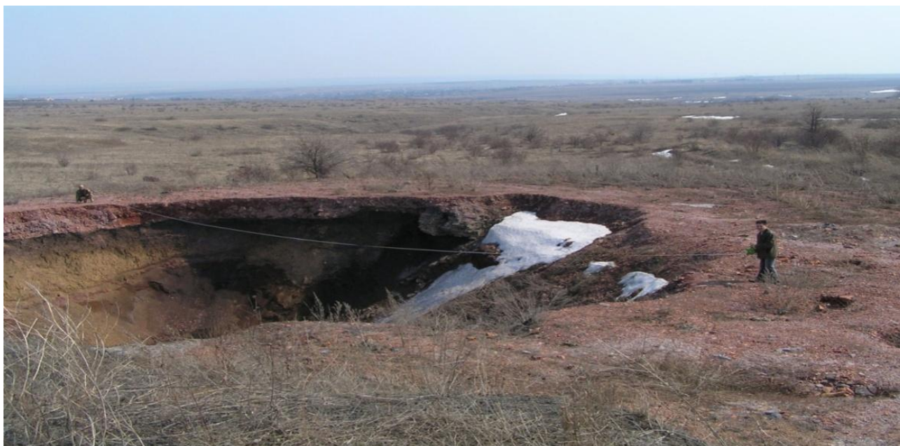
Рис. 1. Провал земной поверхности в устьевой части погашенного наклонного ствола, 2004 г.
