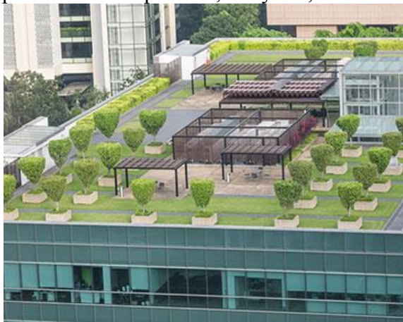
Рис.1. Пример эксплуатируемой озелененной крыши.
