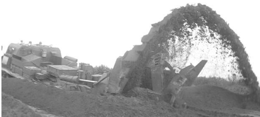
Рисунок 1. Общий вид котлованной машины МДК-3 в процессе работы
