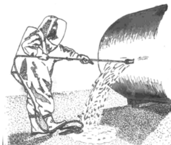
Рис. 5 – Затискання пробійни пневматичною заглушкою
