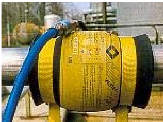
Рис. 2 – Герметизація трубопроводів
