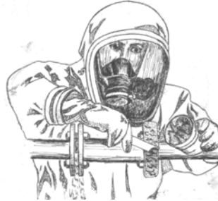
Рис. 3 – Герметизація фланцевих з'єднань
