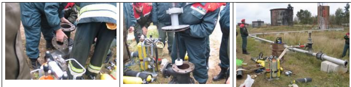
Рисунок 3 - Этапы проведения оперативной врезки.
