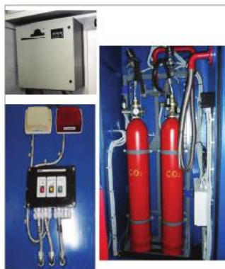
Рисунок 3 – Система противопожарной защиты компрессорных установок
