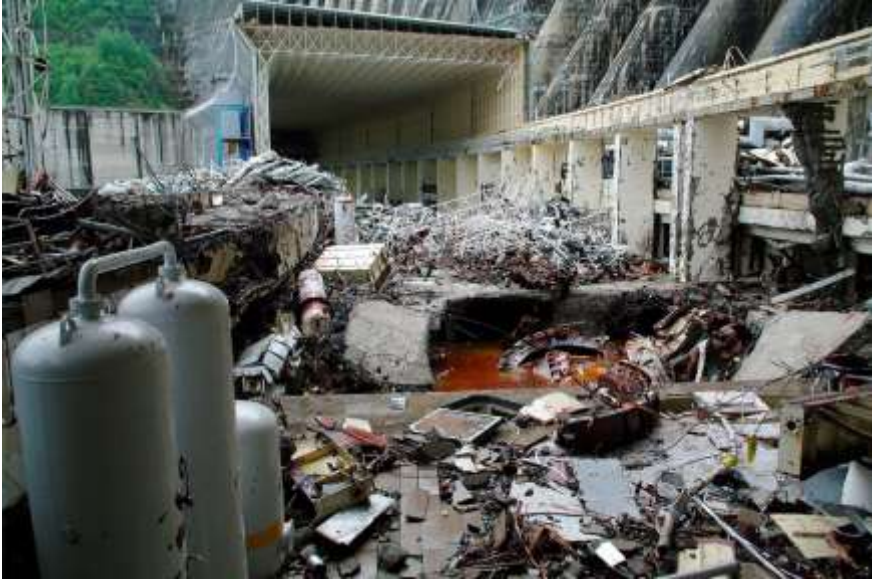
Рисунок 5.19 – Машинний зал Саяно-Шушенської ГЕС після аварії
