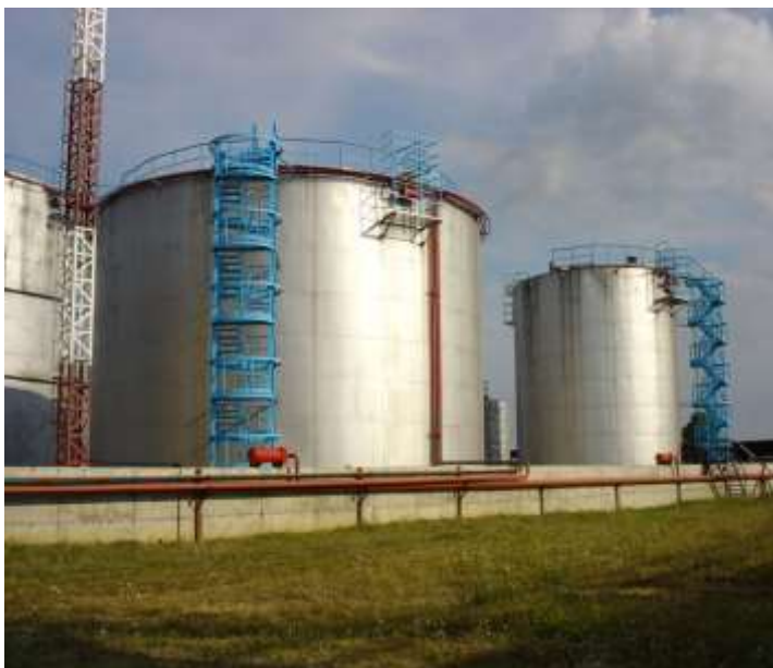
Рисунок 2.12– Резервуар з понтоном
