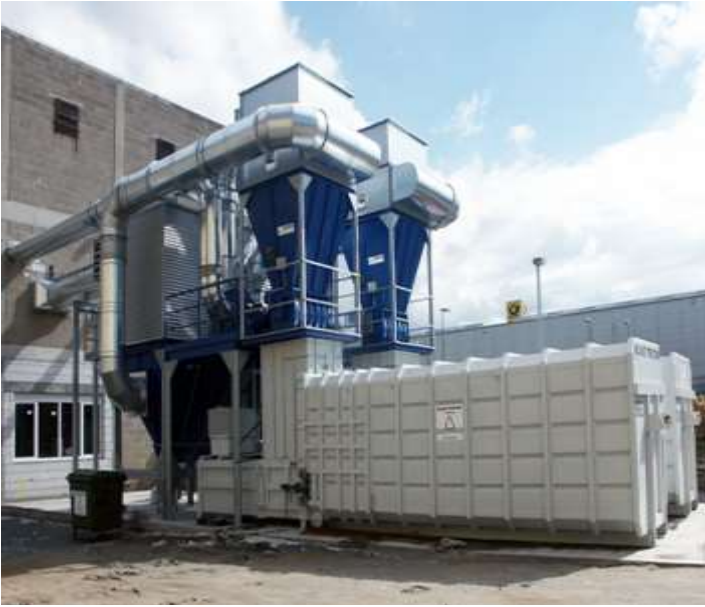
Рисунок 2.20 – Модульна система аспірації
