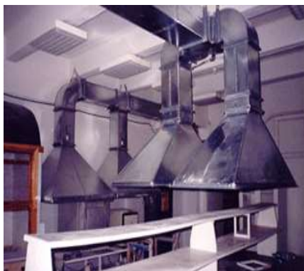
Рисунок 7.3 – Системи аспірації робочих місць у виробничих приміщеннях
