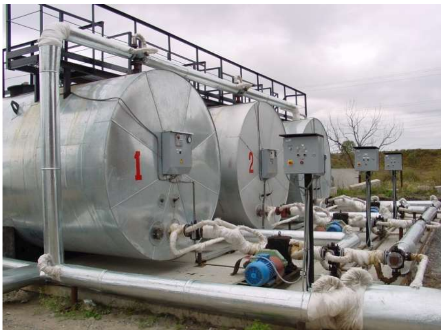
Рисунок 3.4 – Теплова ізоляція наземних резервуарів
