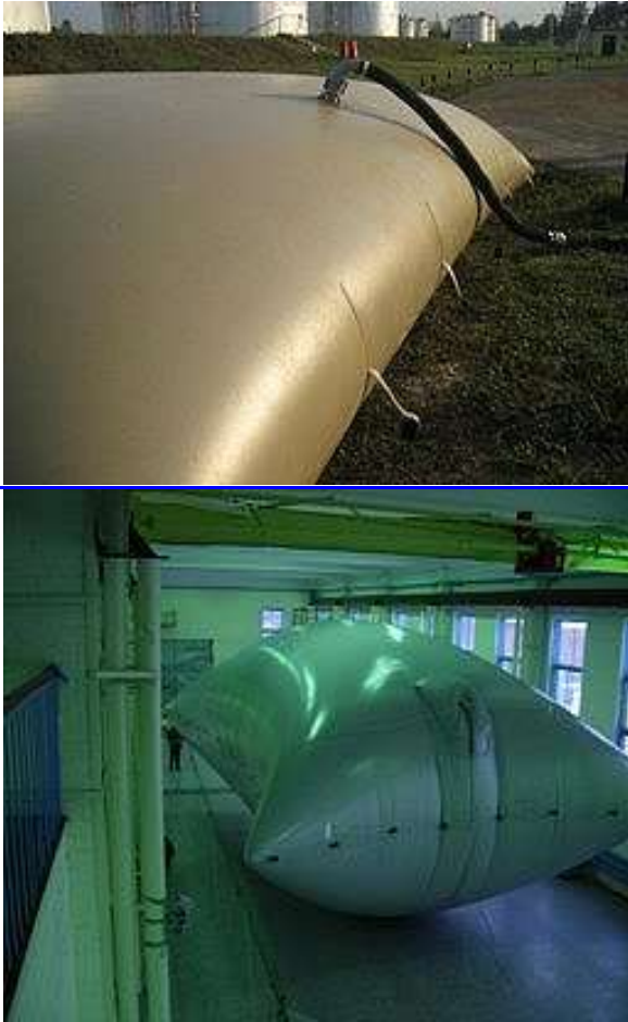
Рисунок 2.14 – Еластичні резервуари та їх розташування
