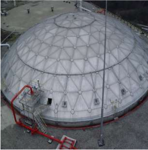
Рисунок 2.10 – Плаваюча покрівля резервуара
