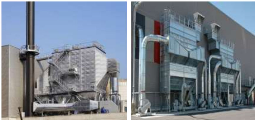
Рисунок 3.23 - Пилоуловлювання системи пневматичного транспортування
