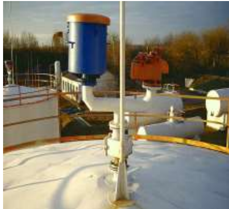
Рисунок 3.7 – Дихальний клапан типу СМКД
