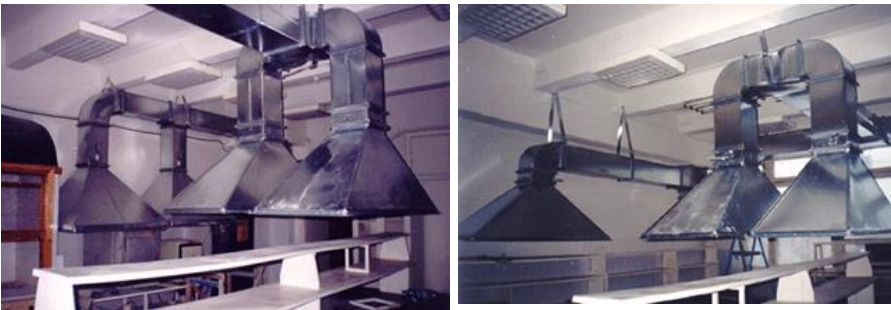
Рисунок 7.3- Системи аспірації робочих місць у виробничих приміщеннях
