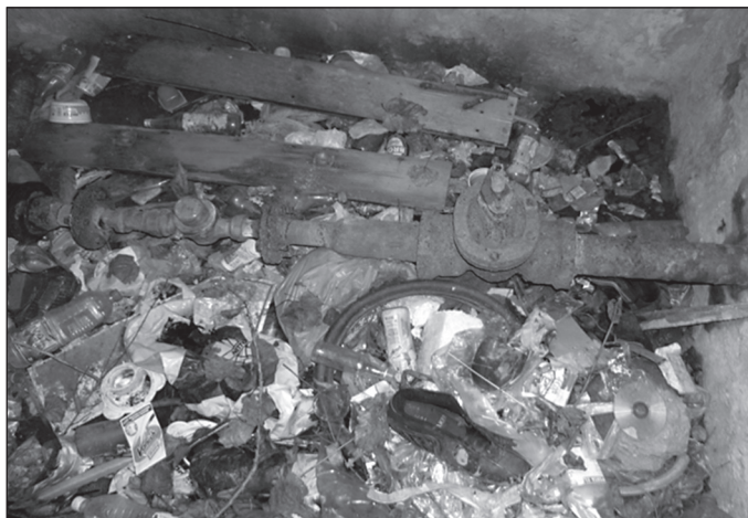
Fot. 7. Widok studzienki instalacji wodociągowej
