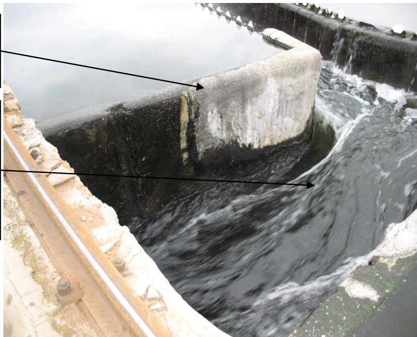
Рисунок 4.5 – Вторичный отстойник
