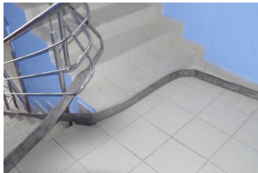
Рисунок 2 – Создание резерва рабочей линии на лестничной площадке
