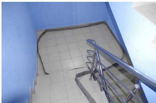
Рисунок 2 – Создание резерва рабочей линии на лестничной площадке
