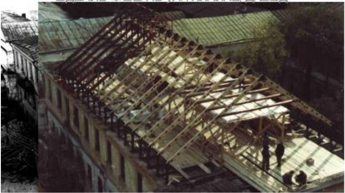
Рисунок 10.2 – Дерев'яні конструкції даху
