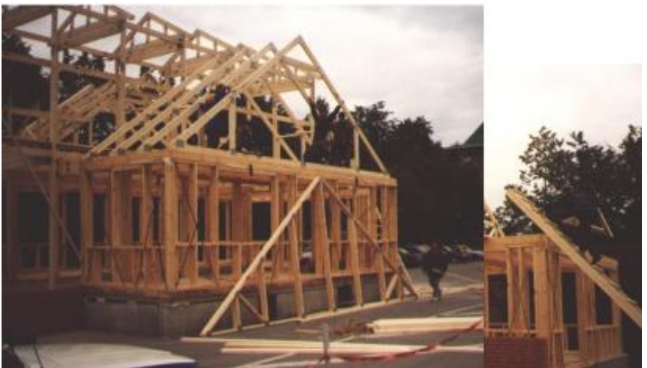
Рисунок 10.3 – Дерев'яний каркас будівлі
