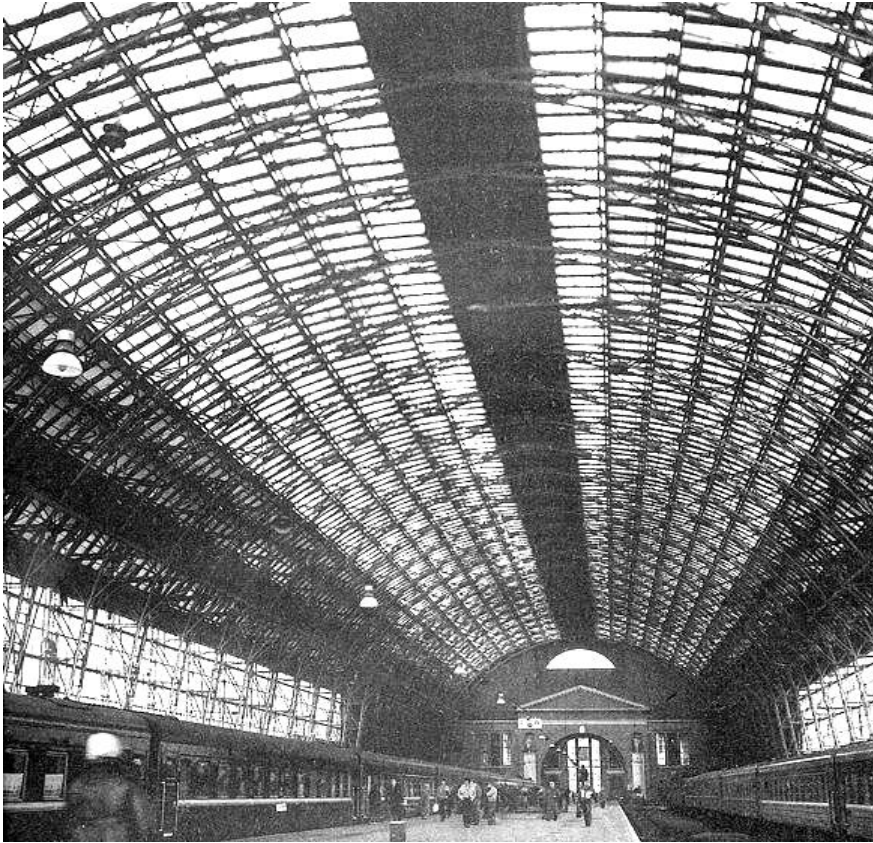
Рисунок 1.11 – Рамно-арочна конструкція дебаркадера Київського вокзалу в Москві (1914 р.)
