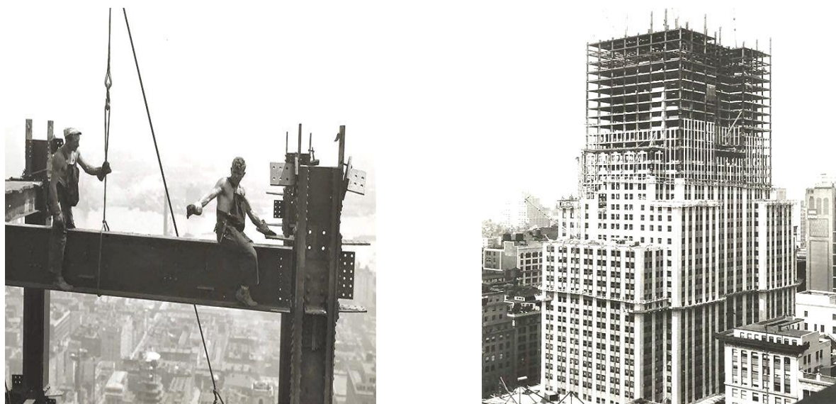
Рисунок 1.17 – Будівництво «Емпайр Стейт» - «восьмого дива світу»
